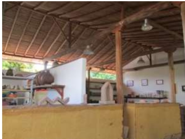
Figura 6. Cubierta de teja de barro y entramado de caña brava, Escuela de Artes y Oficios de Barichara. 2014
