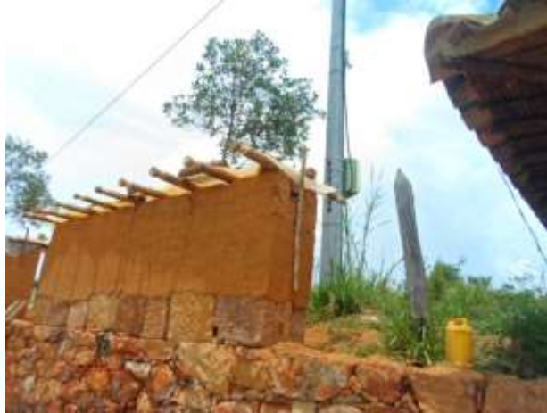
Figura 7. Tacuara o bambusa, llamada comúnmente Guadua - resurgió como un material apto para numerosos usos en la construcción. 2014
