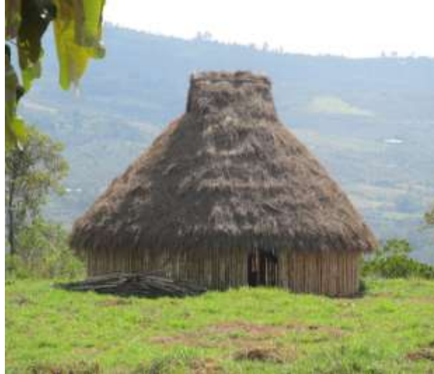
Figura 5, 9 Vivienda indígena tradicional. Cubierta en fibras naturales, con soportes y paredes exteriores en guadua. Barichara, Santander. Colombia
